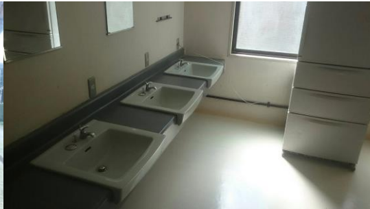
洗面所・洗濯場
