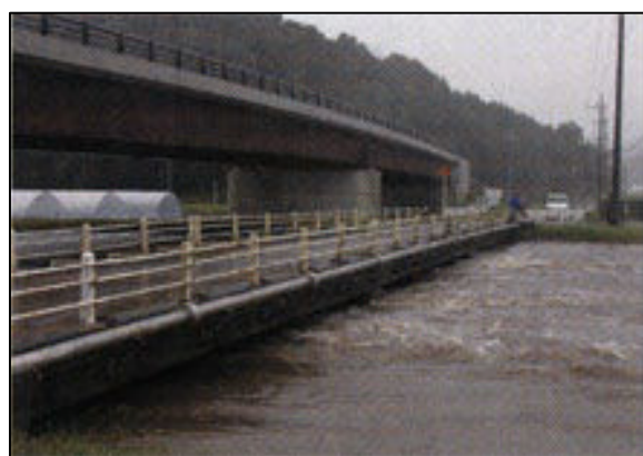
台風(23号)による豪雨(平成16年10月)
