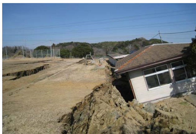
グラウンドの地割れ
